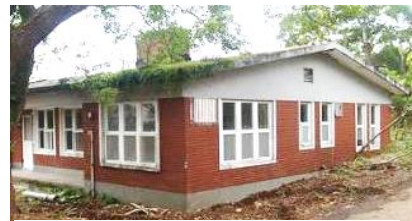
雙坡混凝土磚造建築
